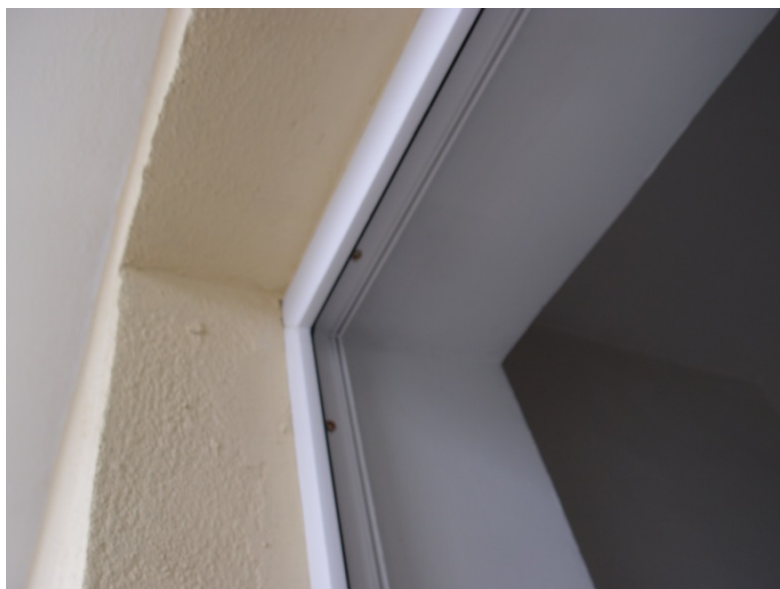
Ф.7 наличие верхнего крепления дверных блоков к стенам.
