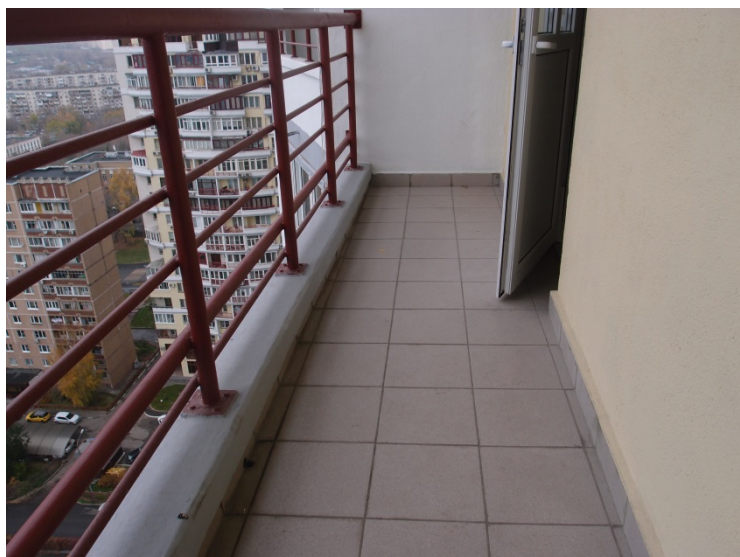
Ф.9. Облицовка полов пожарных балконов
