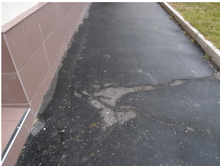
Ф. 9. Фрагмент отмостки со стороны дворового фасада.
