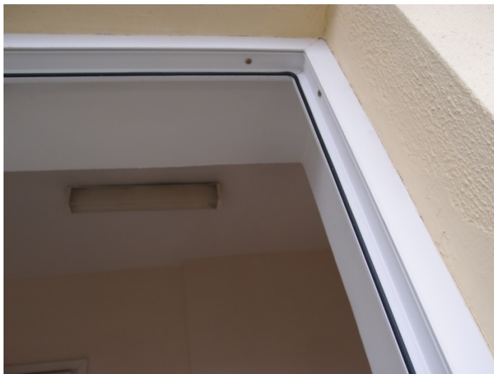
Ф.6 наличие верхнего крепления дверных блоков к стенам.
