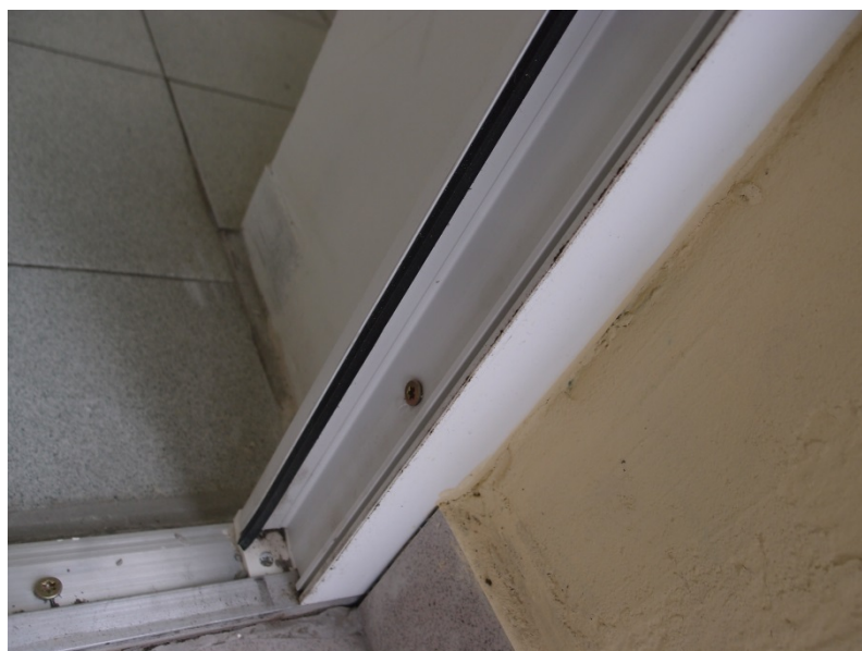
Ф.8 отсутствие в швах паропроницаемых и пароизоляционных герметиков.
