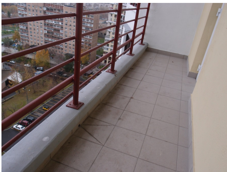
Ф.10. Облицовка полов пожарных балконов
