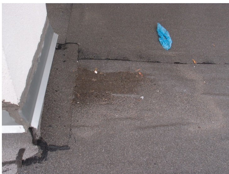
Ф.4. Вздутия на поверхности рулоного ковра.
