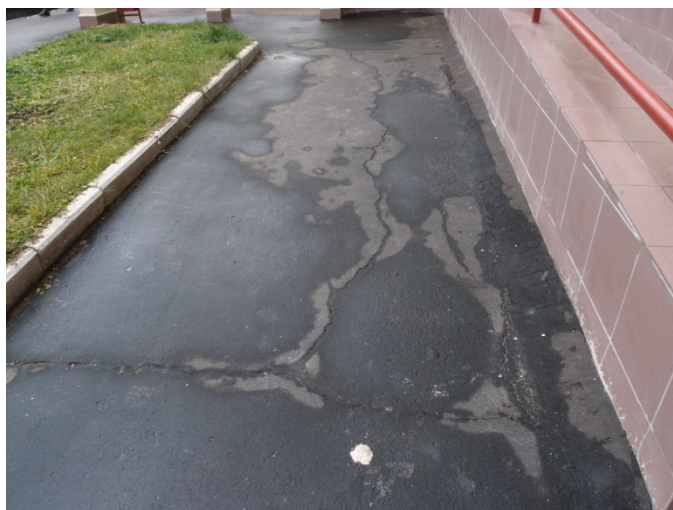
Ф. 8. Фрагмент отмостки со стороны дворового фасада.
