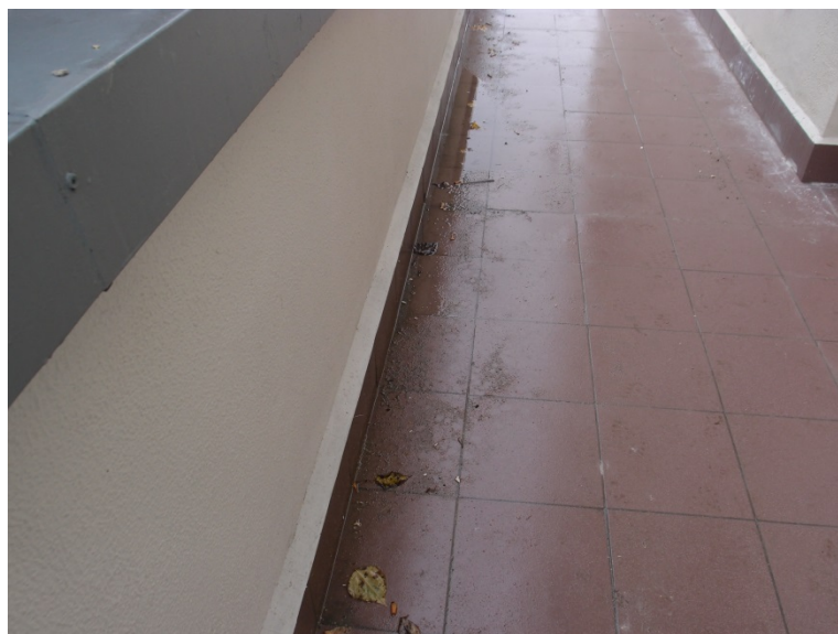
Ф.12. Застойные зоны воды, недостаточная разуклонка.
