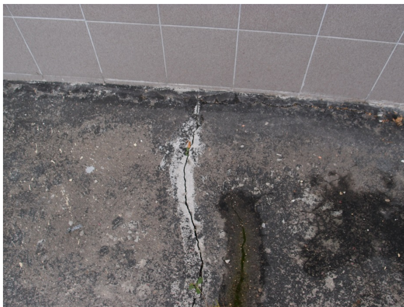
Ф. 10. Фрагмент отмостки со стороны дворового фасада.
