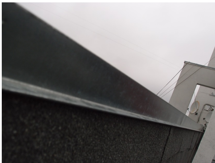
Ф. 3 Отсутствие капельников у окрытий парапетов.
